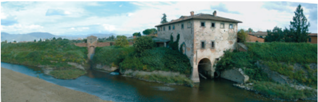
Figura 5: Il Mulino di San Moro. Questo edificio è connesso alla pescaia di Santa Rosa tramite un canale artificiale lungo circa 8 km. Figure 5: The Saint Moro Moulin. This building is connected to the St. Rosa weir by an 8km long artificial channel.
