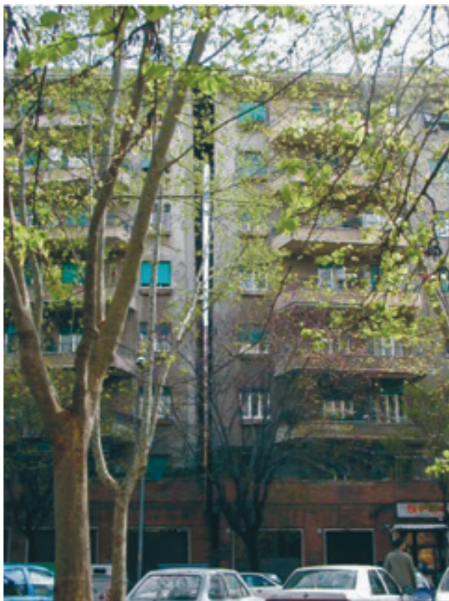
Figura 21. Movimenti rotazionali relativi tra due edifici fondati nel settore marginale della Valle del Fosso di Grotta Perfetta. Figure 21. Relative rotational movements between two buildings resting on the marginal sector of the Fosso di Grotta Perfetta valley.
