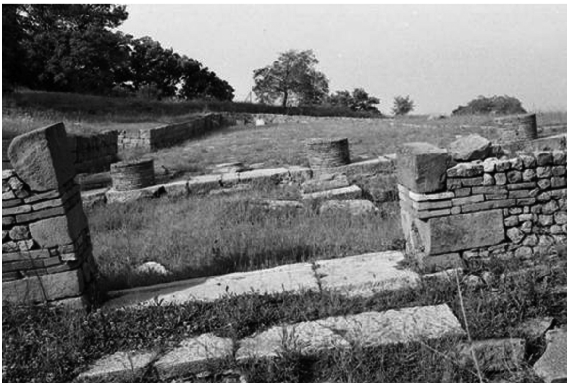
Figura 4 – Basculamento da frana del piano del sagrato e delle strutture in elevazione del tempio. Rotation of the Temple floor and the columns.
